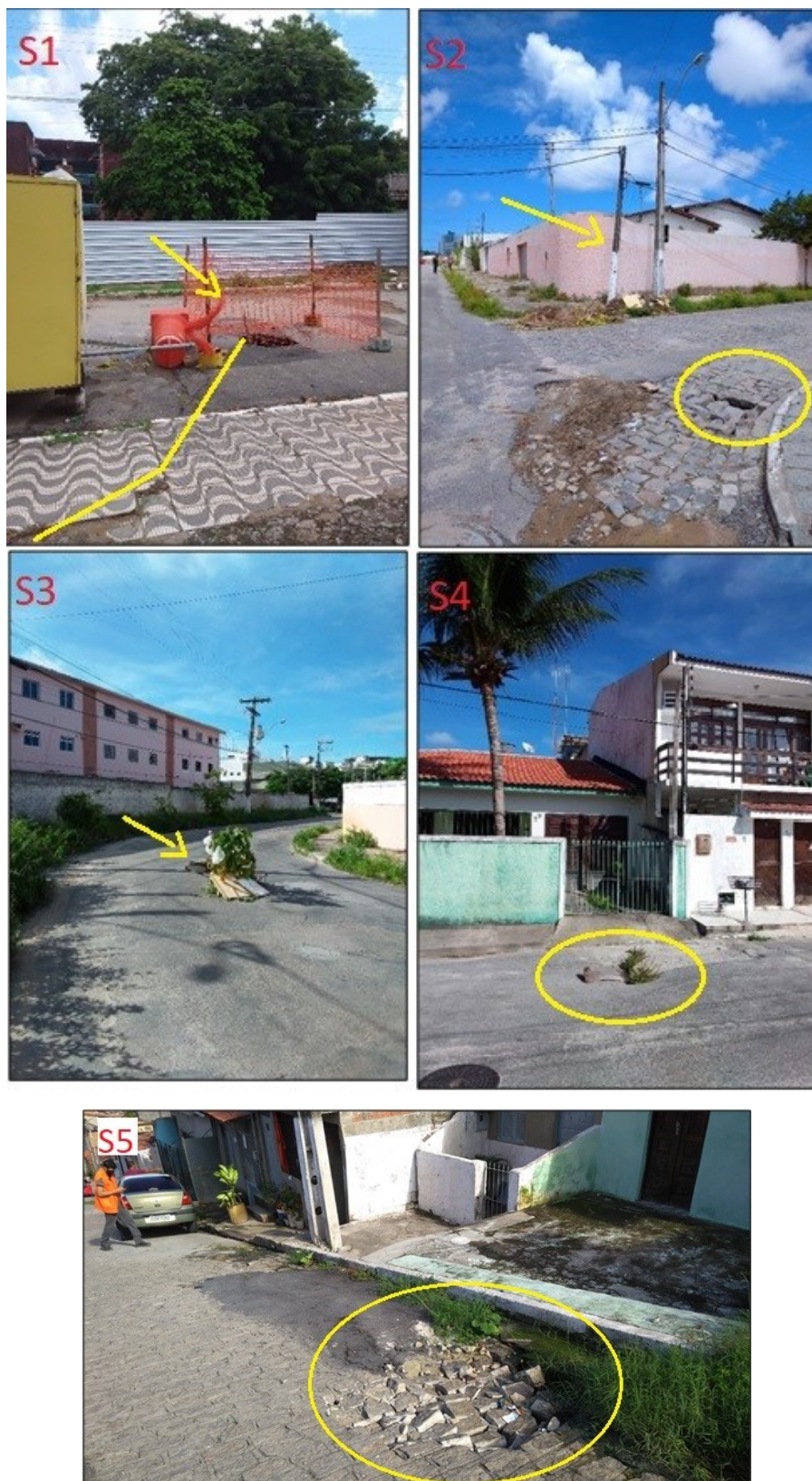
Figura 16 - Formação de “sumidouro” (S1) na linha de feição na praça Menino Jesus de Praga (círculo em amarelo) e inclinação no poste de rede elétrica (seta em amarelo) no cruzamento da Travessa Manuel Menezes e rua Basileu de Meira Barbosa (S2); Formação de “sumidouro” S4 (círculo em amarelo) no cruzamento rua Luiz de Cerqueira Cotrim, Pinheiro.
