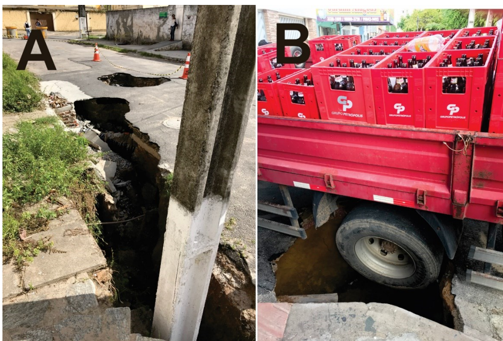
Figura 3 - Processos erosivos a gravados por rompimento de tubulações devido a movimentação do solo. (A) Erosão ocasionada após elevada precipitação (jan/2019). (B) rompimento da galeria pluvial e intensificação de processos erosivos (fev/2019).
